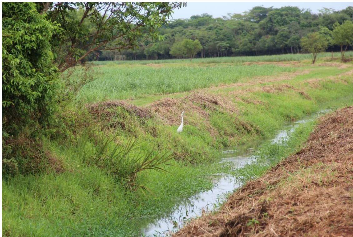
FIGURA 12. Trecho de Valeta de Drenagem em meio aos talhões de cana na Fazenda Barro Preto. Ao centro, uma garça-branca-grande ( Ardea alba ). (Foto: André Ferreira).
